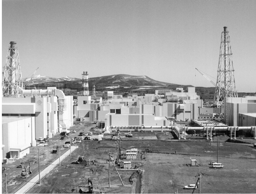
Figure F1-4. Rokkasho-Mura facility (JNFL).
